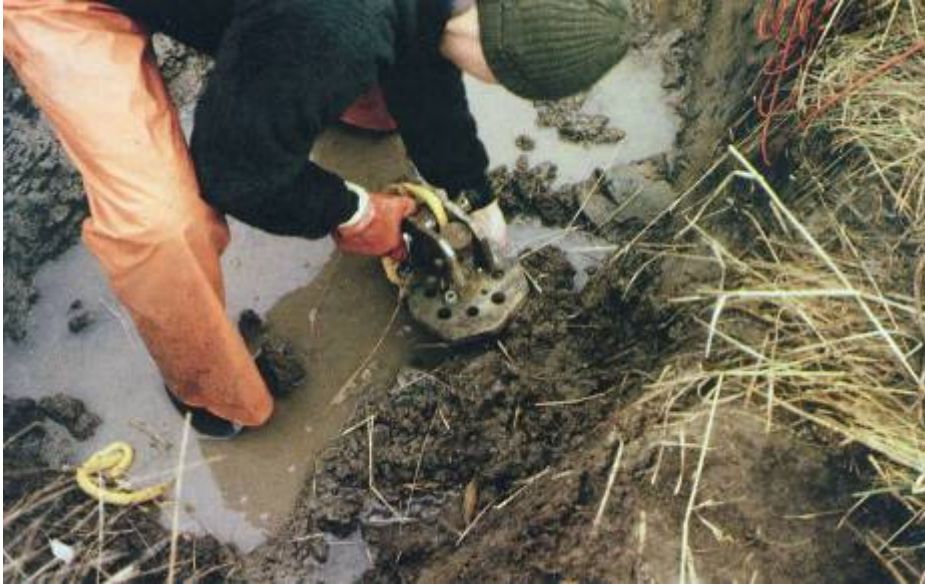
Figur 2.3. Förberedelse för uppdragning av X-påle i den blöta gyttjiga leran på Näset utanför Göteborg. Fästans ordning skruvas fast på X-pålens tryckplatta.
