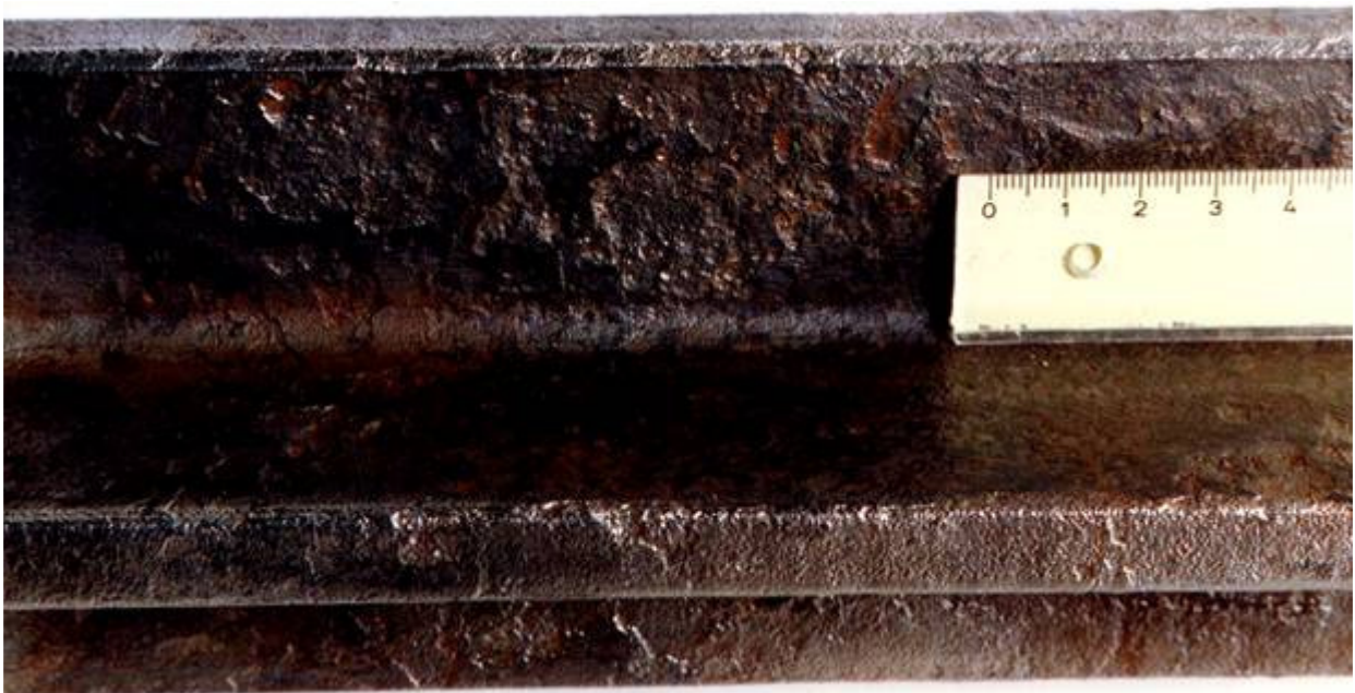
Figur 4.5. Påle exponerad 9 år i gyttjig lera på provningsplats Stockholm, Skå. Angreppens position: 0,3 – 0,6 m under tryckplattan på pålens övre ände. Jämnt rostangrepp med en del loka- la, djupare angrepp i form av frätgropar. Maximalt frätgropsdjup: 0,8 mm.
