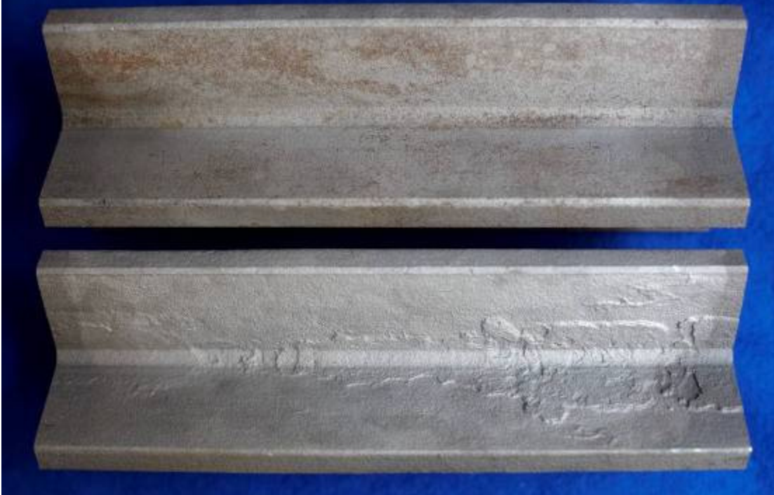
Figur 5.11 Påldelar med nominell längd 0,25 m från X-pålar, som exponerats neddrivna i jord under 27 år på provningsplatserna Enköping (påle nr 24) och Stockholm (påle nr 17).
