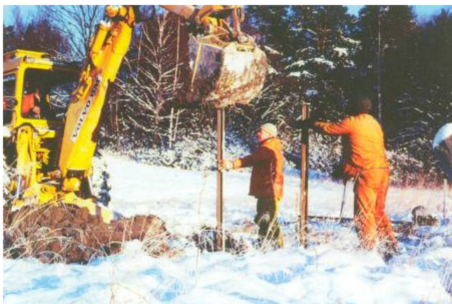
Figur 2.2 Stålpålar (X-pålar) trycks ned i den ostörda jorden med hjälp av en grävmaskin på prov- ningsplats Sollentuna.
